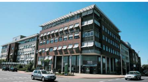
Am Stammsitz der Kreisverwaltung Pinneberg befindet sich das zentrale Rechenzentrum der Kommunit.
