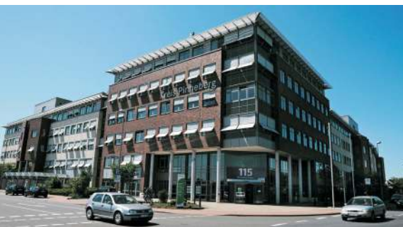
Am Stammsitz der Kreisverwaltung Pinneberg befindet sich das zentrale Rechenzentrum der Kommunit.
