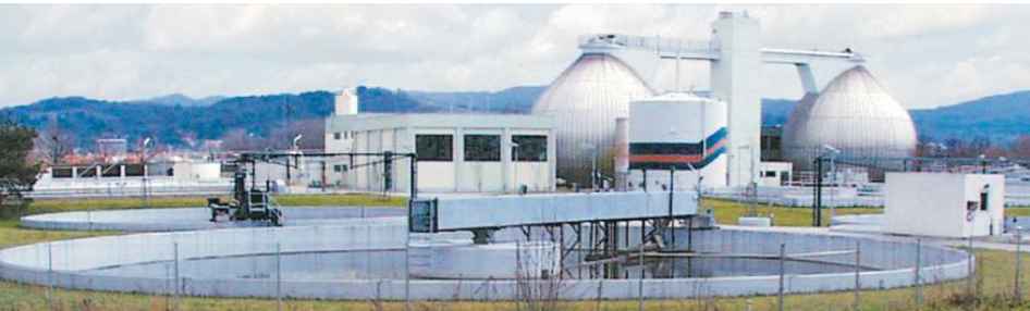
Der Betrieb der Kläranlage gehört zu den Aufgaben der KMB
